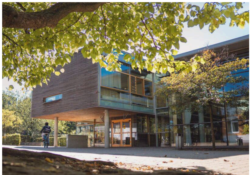
Mittelstufengebäude der Bugenhagenschule Alsterdorf
